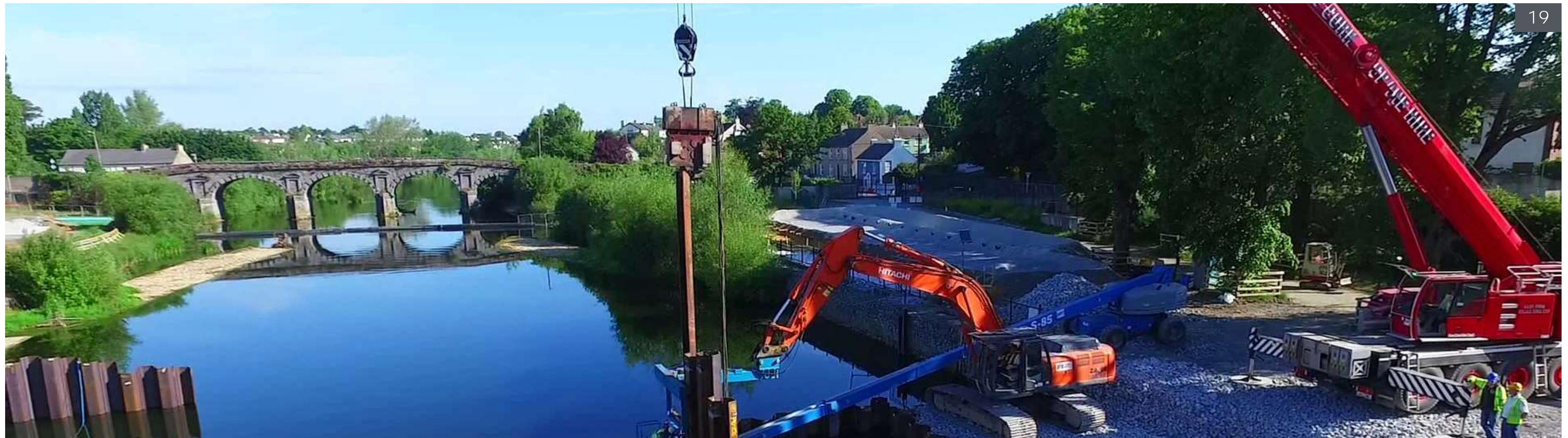
Dewatering and Silent Piling are capacitatea de a realiza orice tip de proiect cu palplanșe, fie temporare sau definite, disponând de cele mai avansate utilaje din domeniu: vibrociocane cu frecvență înaltă și moment variabil, presă hidraulică pentru presarea și extragerea statică a palplanselor, fără vibrații și cu emisii fonice minime, utilaje perfecte pentru șantiere situate în vecinătatea unor clădiri sensibile sau în centre locuite.
