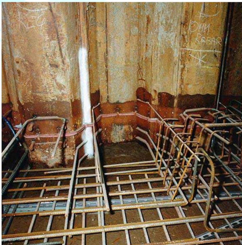
Conexiunea dintre peretele de palplanse si elementele constructiei:
